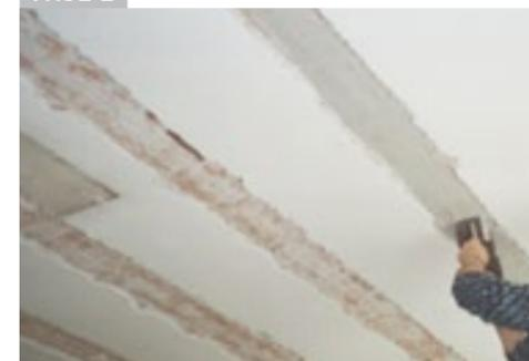
Applicazione della resina epossidica ARMOFIX MTL per l'incollaggio delle lamelle
