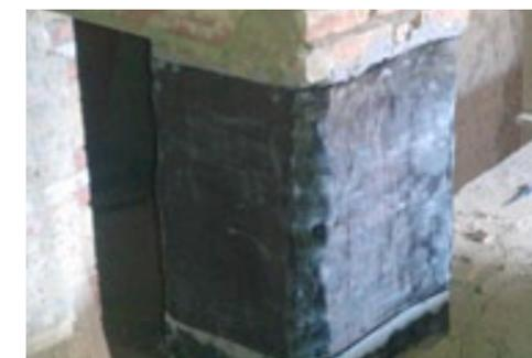
Cerchiatura del pilastro con tessuti in fibra di carbonio ARMOSHIELD C
