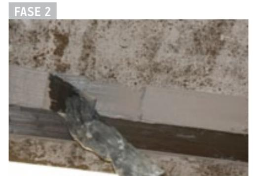
Applicazione dell'adesivo epossidico ARMOFIX MTL specifico per l'applicazione delle lamelle
