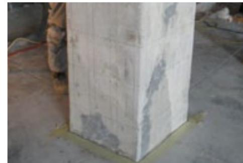
Ricostruzione volumetrica del pilastro con malta fibrorinforzata della linea flueco
