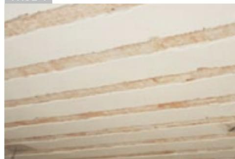
Demolizione del fondello in laterizio e pulizia delle superfici
