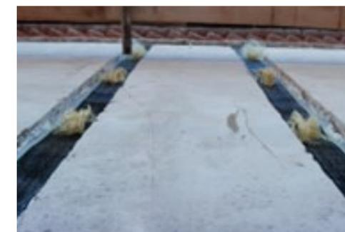
Posa dei tessuti in fibra di carbonio ARMOSHIELD C sulle corsie di malta e inserimento dei connettori ARMOGRIP
