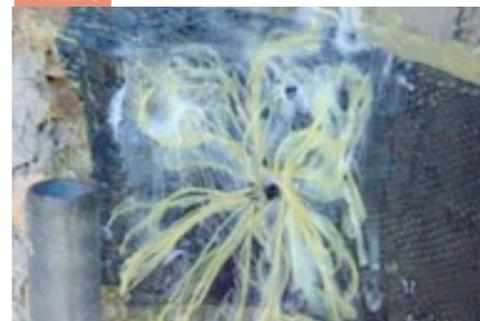
Apertura a ventaglio e fissaggio del fiocco con la resina epossidica ARMOFIX MTX
