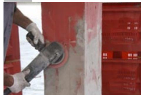
Rimozione del rivestimento esistente e pulizia
