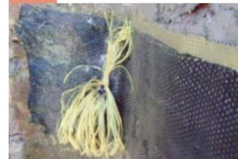
Inserimento del connettore aramidico ARMOGRIP BC all'interno del foro riempito con la resina ARMOFIX
