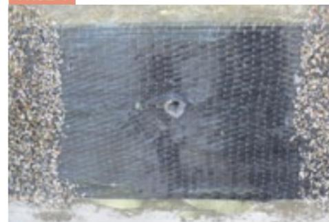
In corrispondenza dei fori le fibre vanno accuratamente allargate
