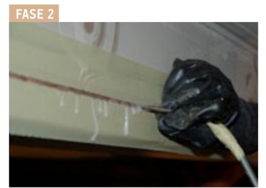
Iniezione dell'adesivo ARMOFIX MTX
