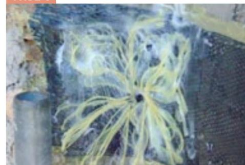
Apertura e fissaggio del fiocco con ARMOFIX MTX
