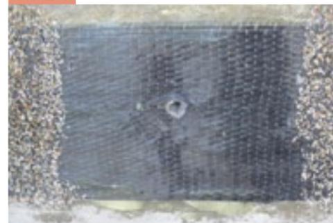
In corrispondenza dei fori le fibre del tessuto in carbonio vanno accuratamente allargate
