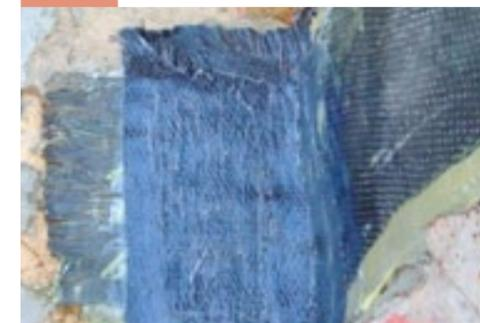
Porzione di tessuto in fibra di carbonio applicato sul fiocco a protezione del connettore
