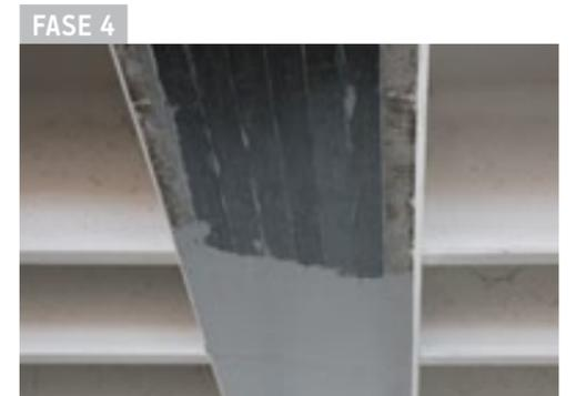
Applicazione dell'adesivo ARMOFIX MTX sulle lamelle fino a totale copertura
