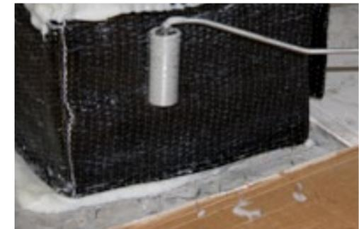
Posa in opera del tessuto ARMOSHIELD C-SHEET e impregnazione con resina epossidica ARMOFIX MTX
