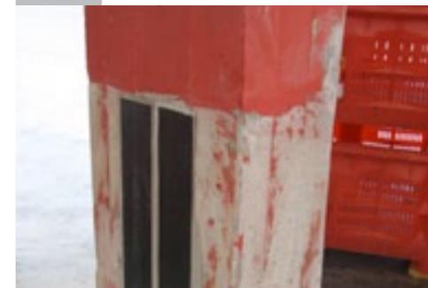
Applicazione dell'adesivo epossidico di incollaggio ARMOFIX MTL e delle lamelle ARMOSHIELD CFK
